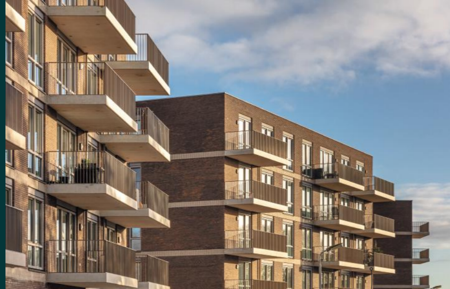
Bachweg Amersfoort, Corridor
