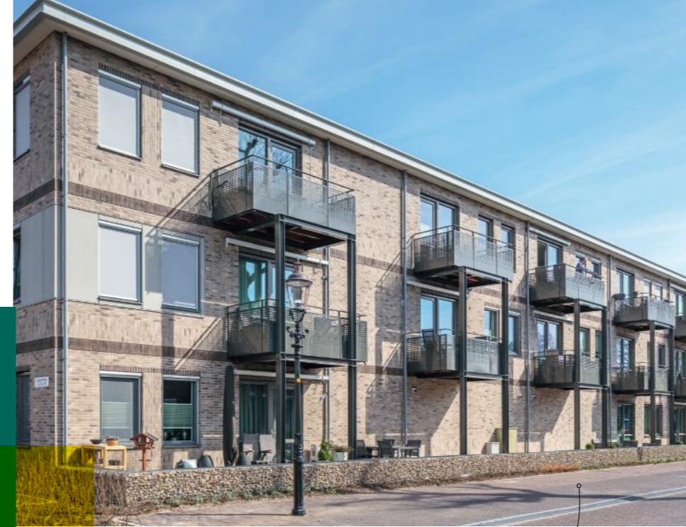
Blokje Omhoog Losser, voorgevel
